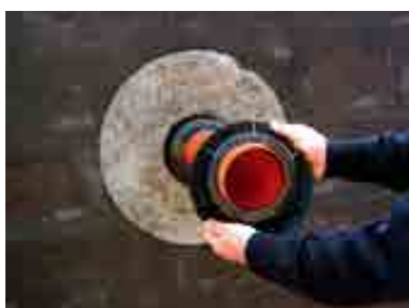
4. Установить фиксирующую гайку
